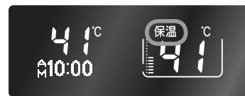
浴室リモコン
